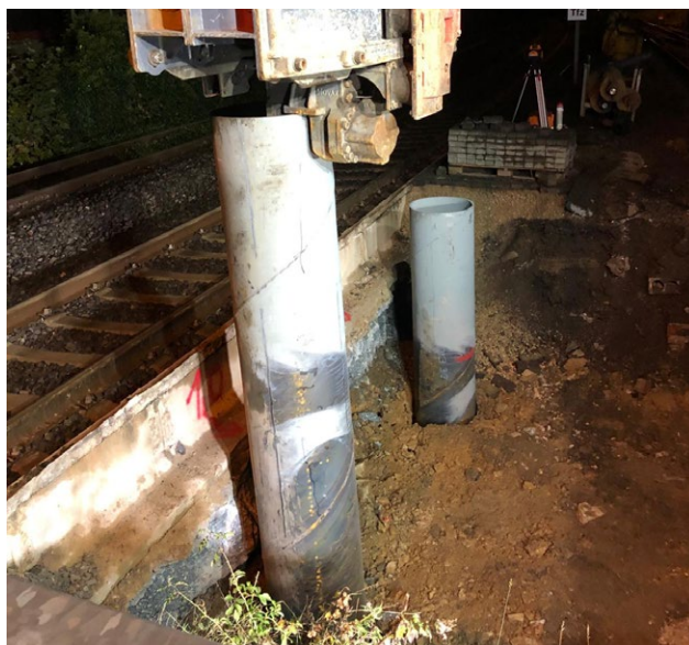
Einbringen der Rammrohre mit einer Movax Hochfrequenz-Vibrationsramme
