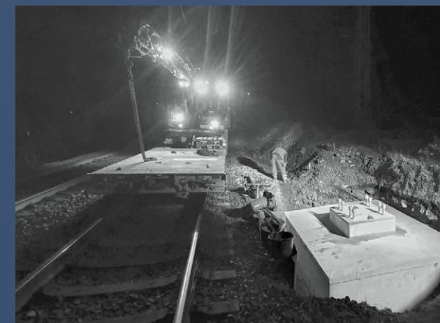
Fundamente mit Verankerung
