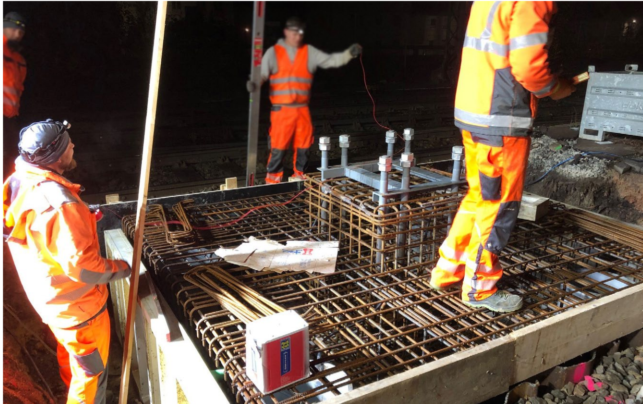
Bewehrungs- und Schalungsarbeiten
