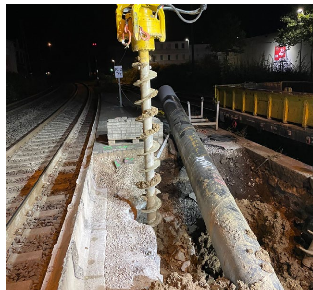
Auflockerungsbohrungen des Baugrunds mittels Bohrschnecke
