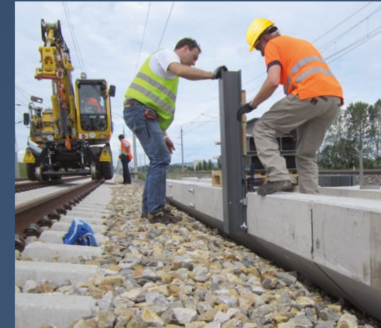
Setzen der Pfosten
