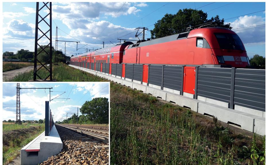
Abb. 1: Noise Breaker im eingebauten Zustand
