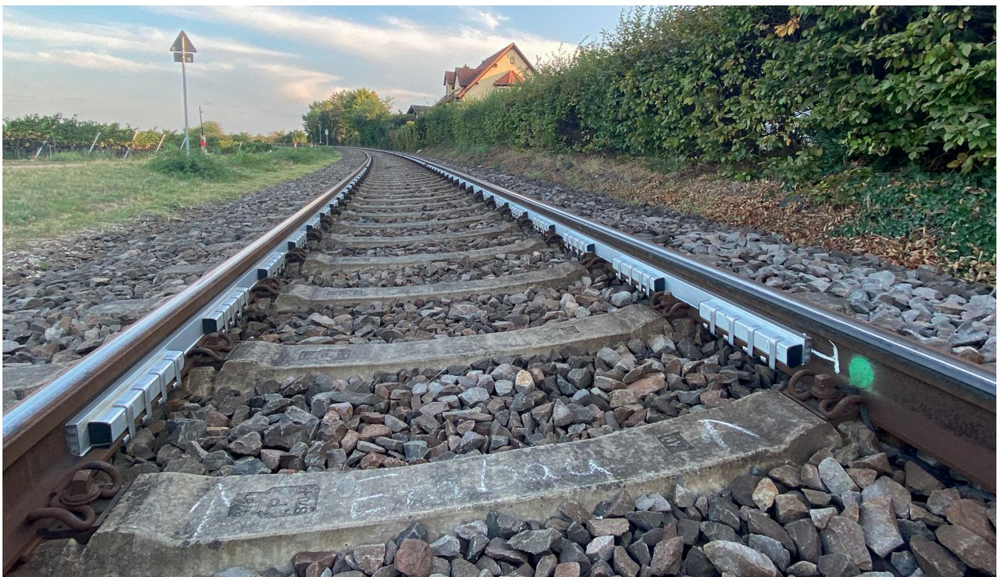
**Abb. 1:** Das LABTMD Schienenstegdämpfungssystem mit vier Klammern
