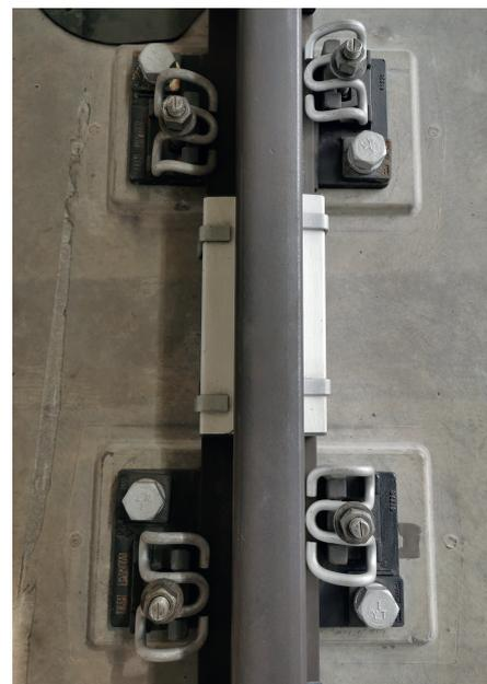
**Abb. 2:** Fertiger Zustand des LABTMD mit zwei Klammern. *Quelle: Create Green Environment*
